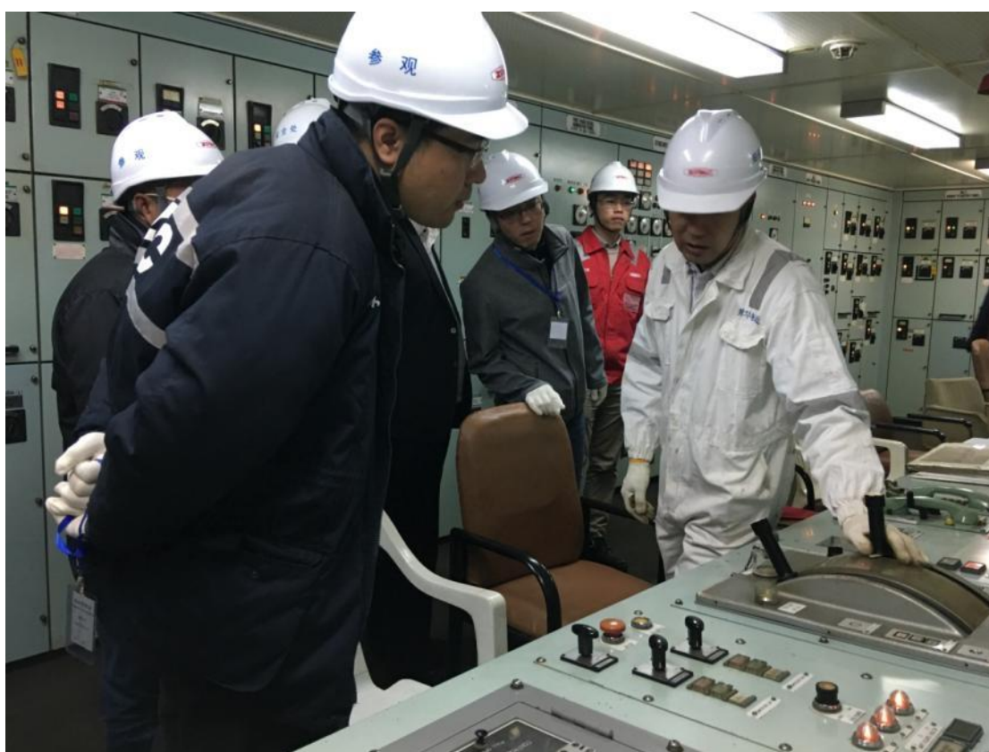
安全检查现场
