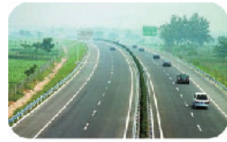
高速公路管理系统
