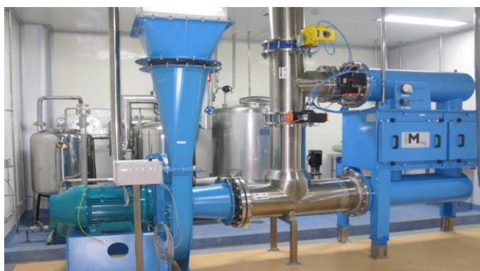
车间先进的除尘排风系统
