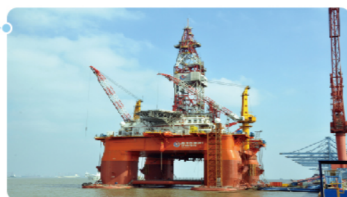
“海洋石油981”超深水半潜式钻井平台
