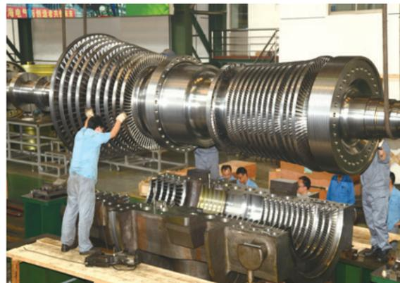
乐清改造项目高中压缸正在落转子
