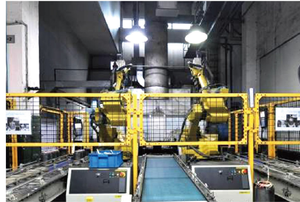
存在噪音危害的冲床岗位采用机器人替代人工操作
