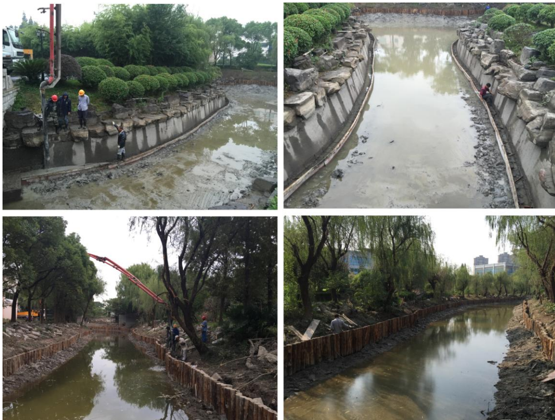
三面浜河道整治施工
